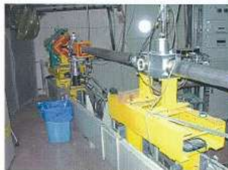
《一時撤去 作業前》
