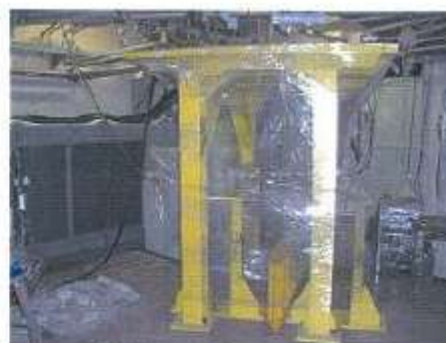
《一時撤去、同室内に移動、養生》
