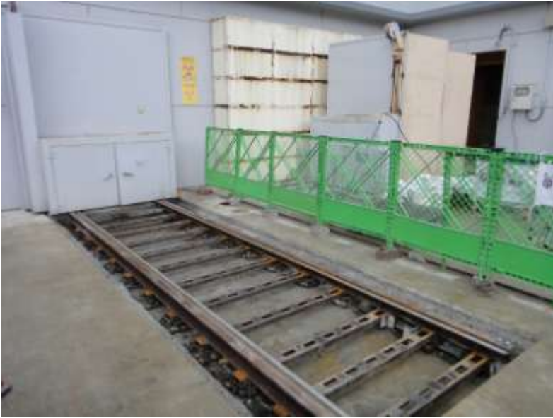
⑤ レールの敷設、軸出し、水平出し
