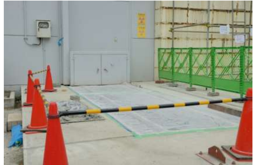
⑥ コンクリート打設後の養生
