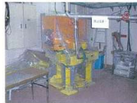
《電磁石 一時撤去、同室内に移動、養生》
