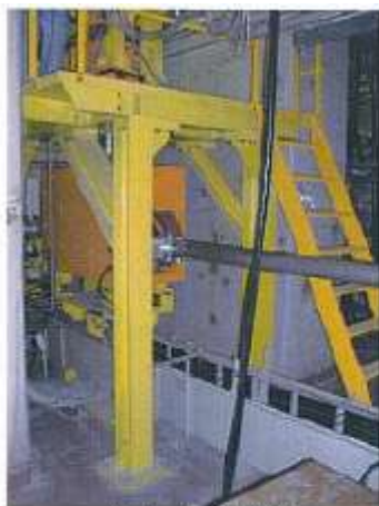
《一時撤去 作業前》
