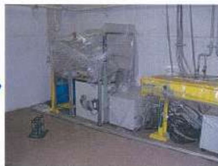
《一時撤去、同室内に移動、養生》
