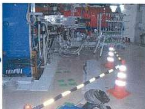
《一時撤去 作業後》
