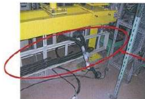
《電線ラック 一時撤去》
