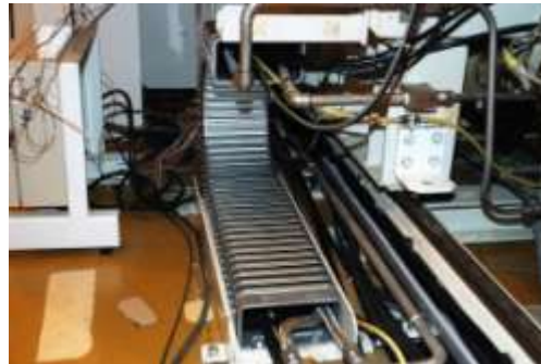
冷却水・圧空ダクト
