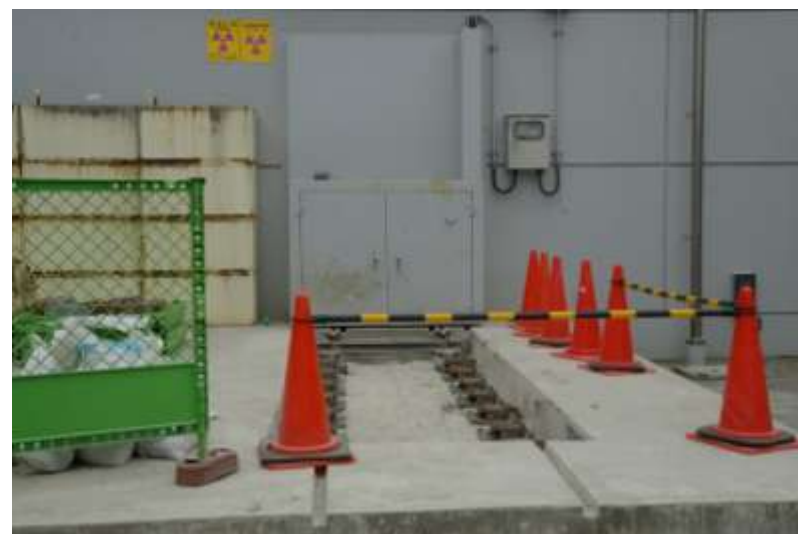
④ レール用ベースを設置
