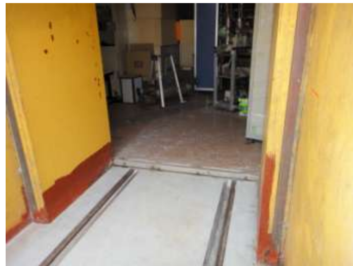
② 内側コンクリート打設
