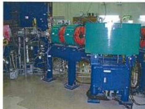
《一時撤去 作業前》
