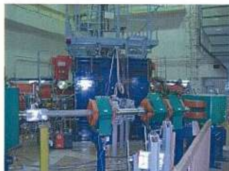
《一時撤去 作業前》
